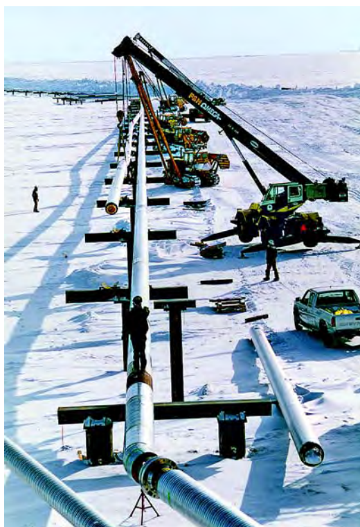
普拉德霍湾垂直支撑架上隔热的 24 英寸 2205 管的安装（来源：Arco Exploration and Production Technology）
