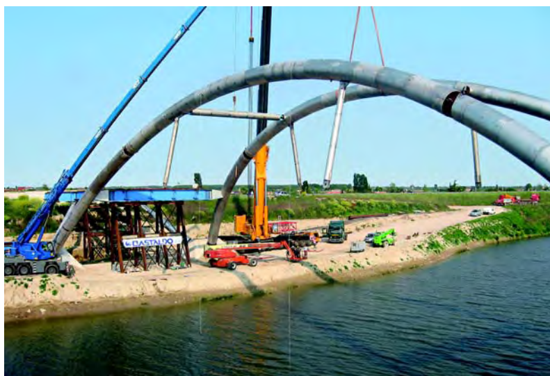
意大利帕多瓦附近正在建造的 2304 双相不锈钢桥梁拱形结构（来源：AreelorMittal）
