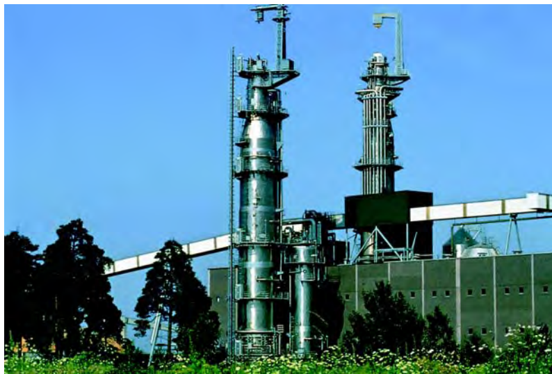
瑞典 Sodra Cell Mönsterås 纸浆厂的 2205 双相不锈钢硫酸盐纸浆连续蒸发器 和浸渍塔（来源：Kvaerner Pulping）
