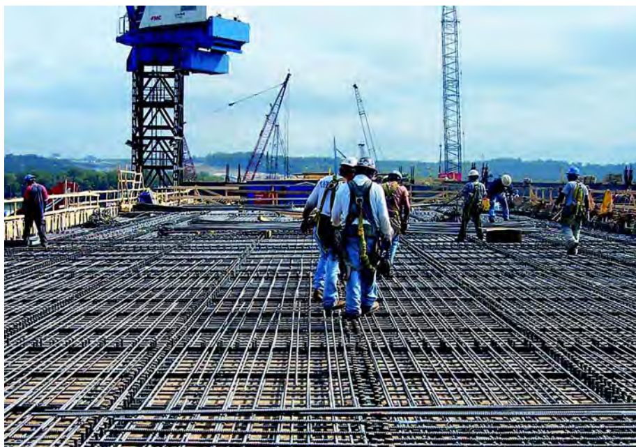
一座大型桥梁桥面上双相不锈钢钢筋的安装 (来源: Hardesty & Hanover, LLP)
