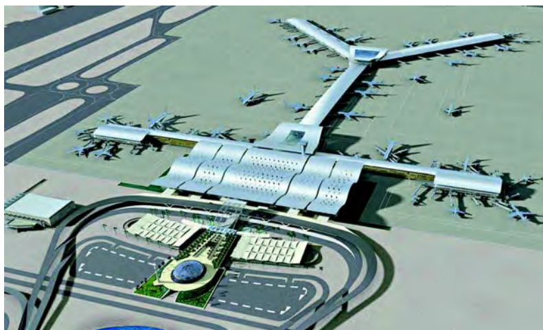
使用不锈钢屋顶的多哈新国际机场（来源：Qatar Airways）
