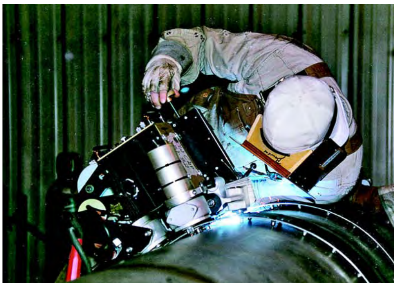
阿拉斯加北坡的大直径双相不锈钢管道的机械化焊接(来源: Arco Exploration and Production Technology)
